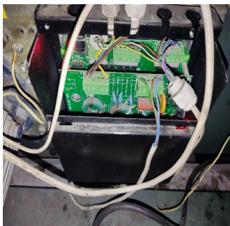
БУАД под замену
